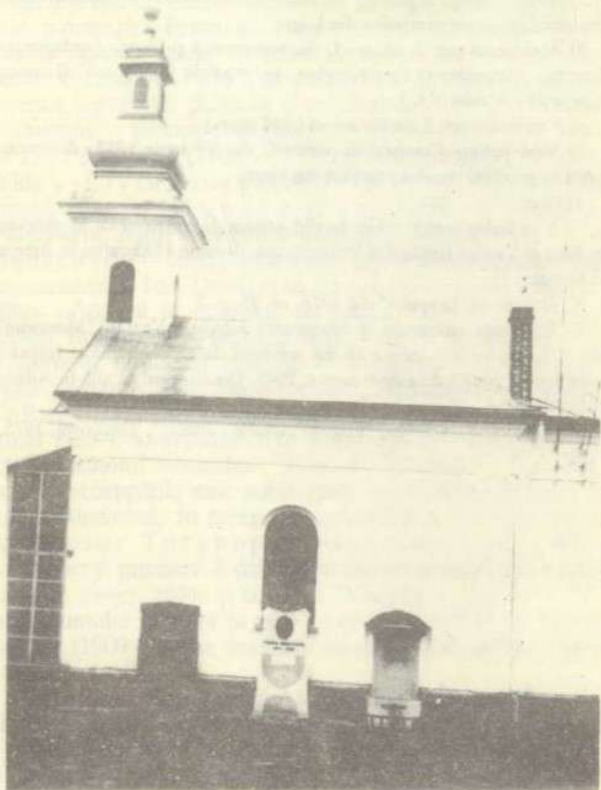
Capela cimitirului (partea dreaptă)
